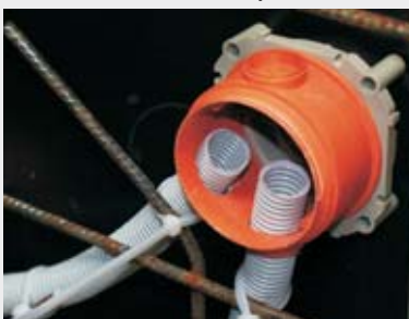
Namontované ohebné trubky do tělesa KBT.
