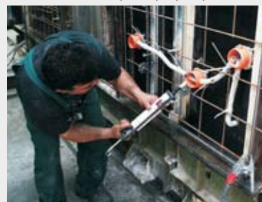
Utěsnění prostupů (tmel).
