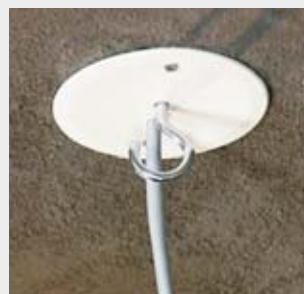
Krabice KBT... zakrytá víčkem V 68 S s vyvedeným vodičem a lustrákem KBT...
