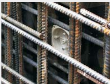
Víčko KBV připevněné na bednění.
