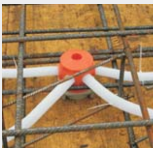
Příklad použití na horizontální bednění.
