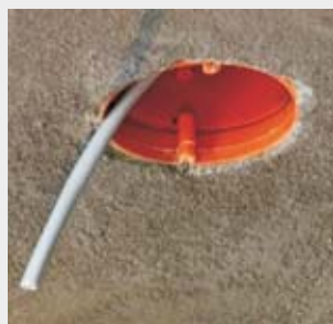
Krabice KBT... s vyvedeným vodičem připravená pro montáž lustrů KBT...
